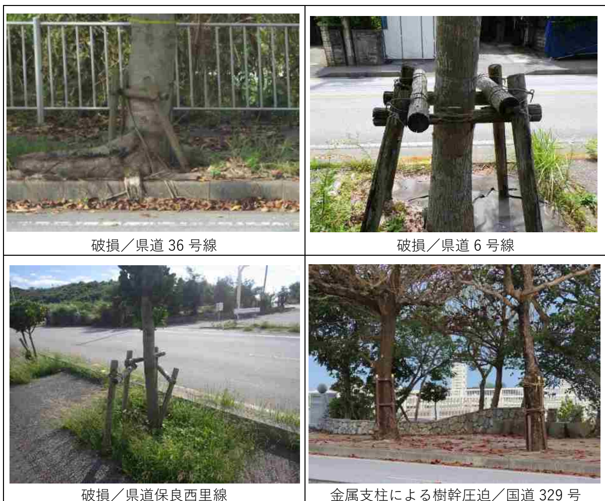
写真 2.5.3 機能を果たしていない支柱
