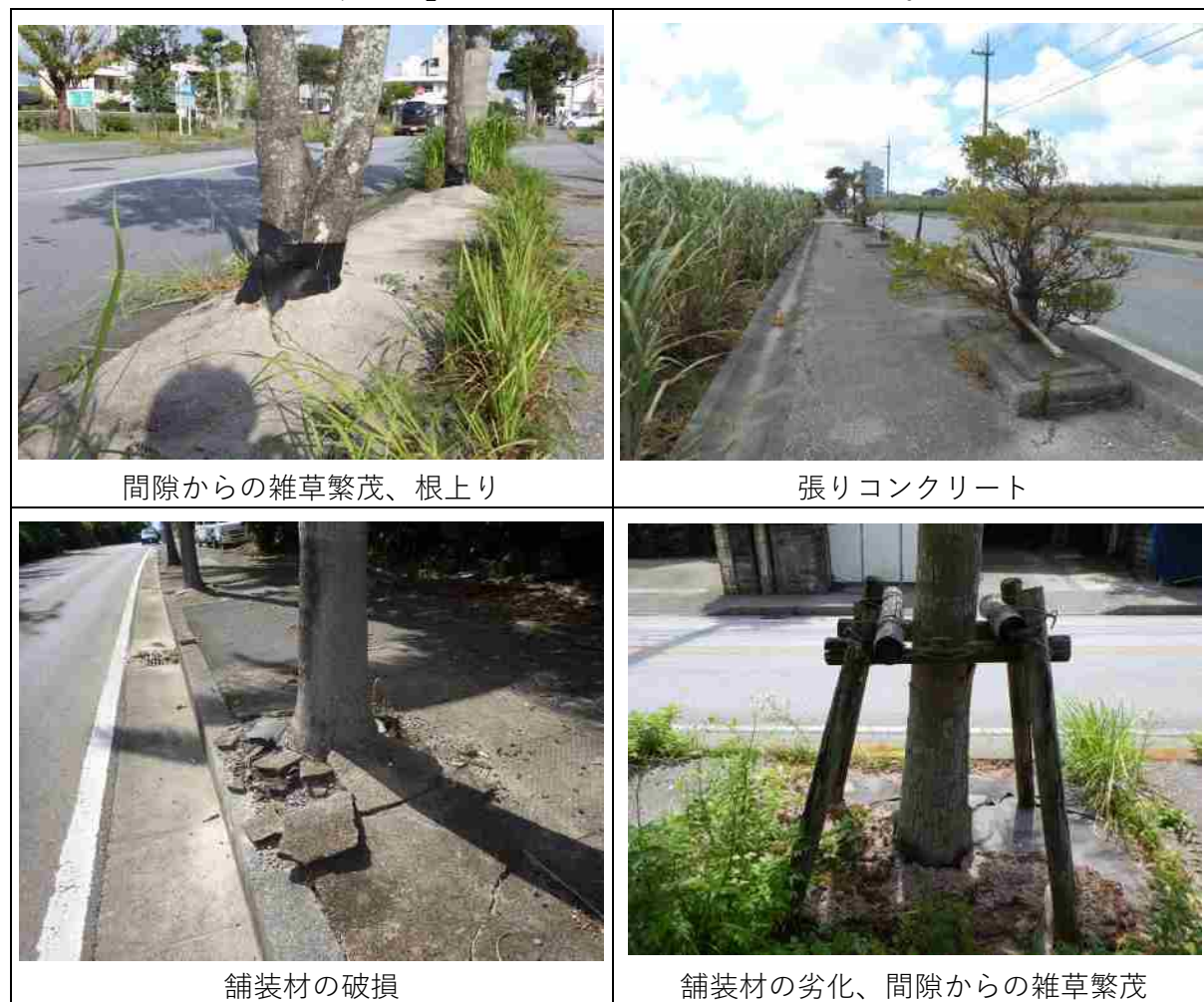
写真 2.5.4 植樹柵及び植樹帯における地表面被覆の事例
