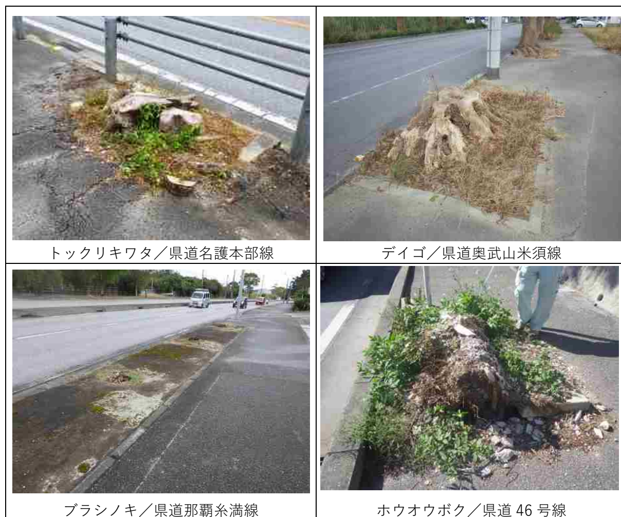
写真 2.5.2 切株のみが残されている植樹柵や植樹帯
