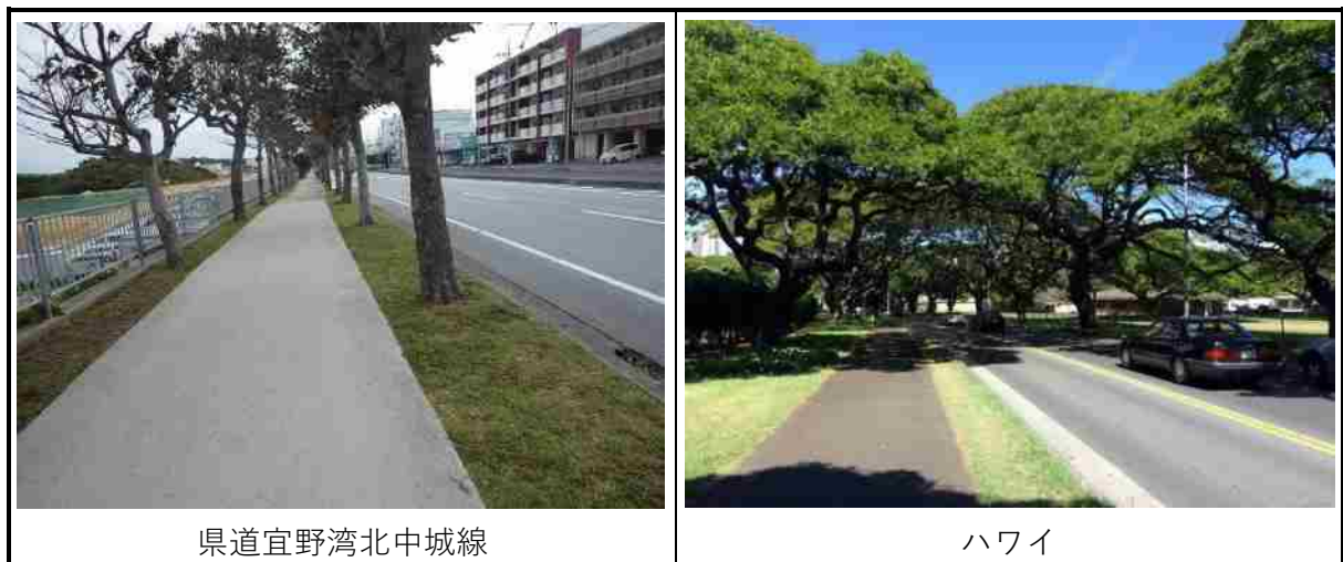
写真 2.4.3 植栽地面との段差解消、歩道舗装面の縁石を設置していない事例
