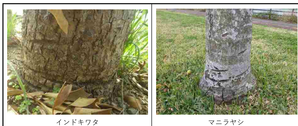
写真 3.2.1 刈払機による根元の損傷
