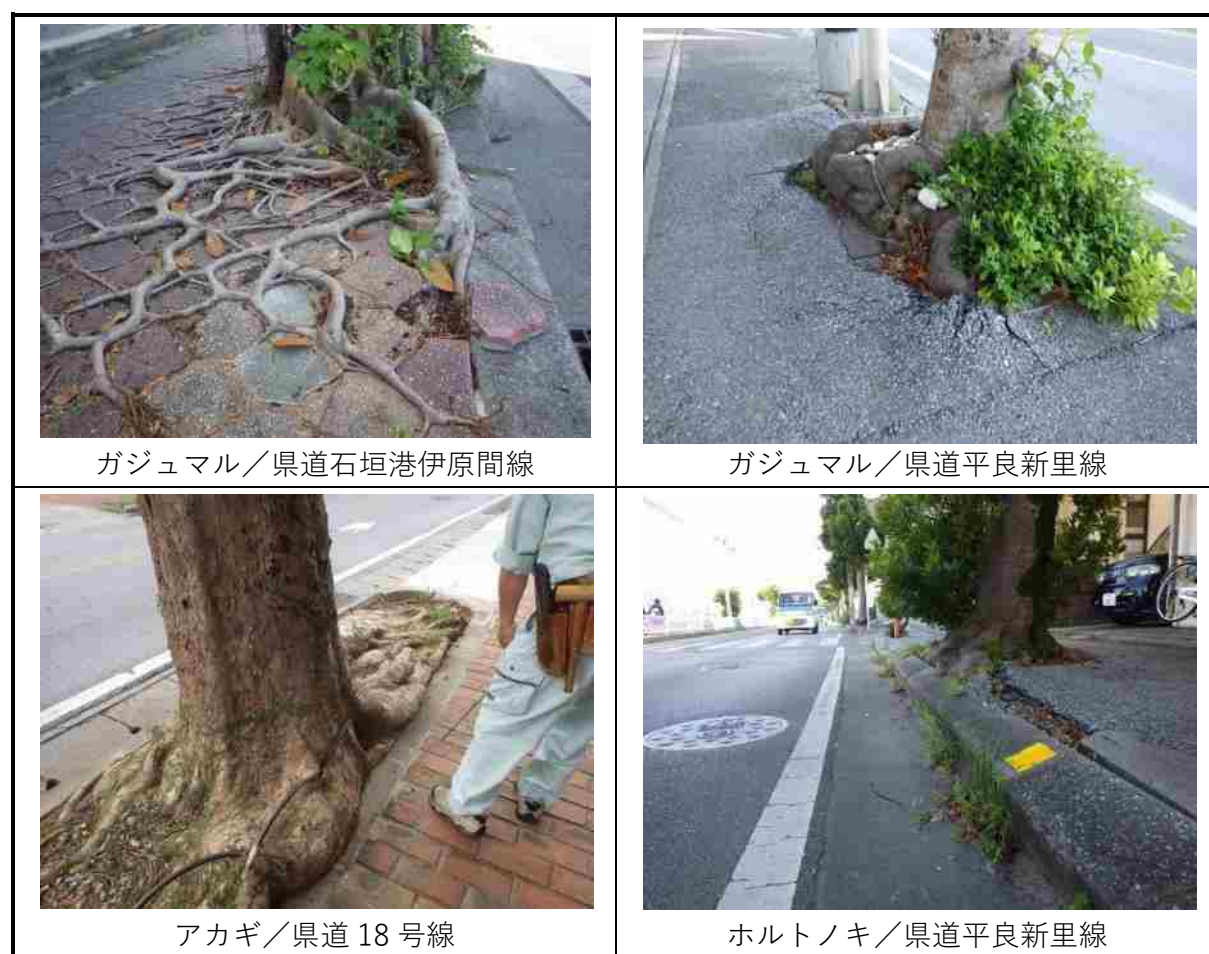
写真 2.2.1 樹木の成長に配慮していない植栽基盤の状況
