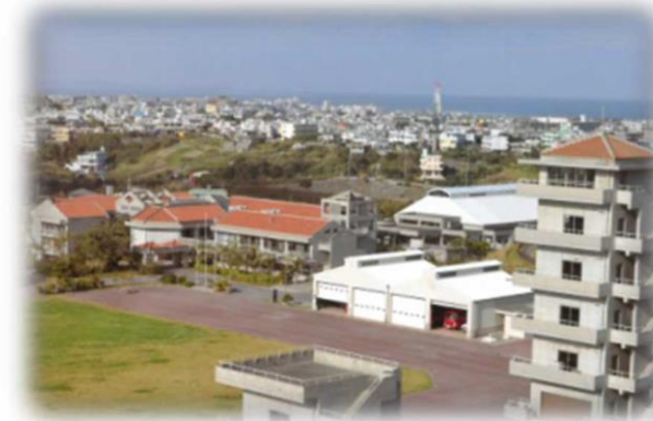
沖縄県消防学校
