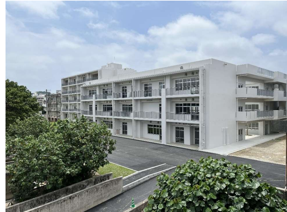
令和5年度に完成した学校（宜野湾高校校舎改築工事(第2期)）
