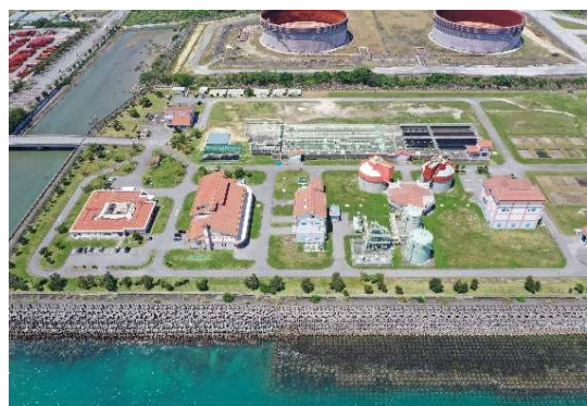
西原浄化センター
