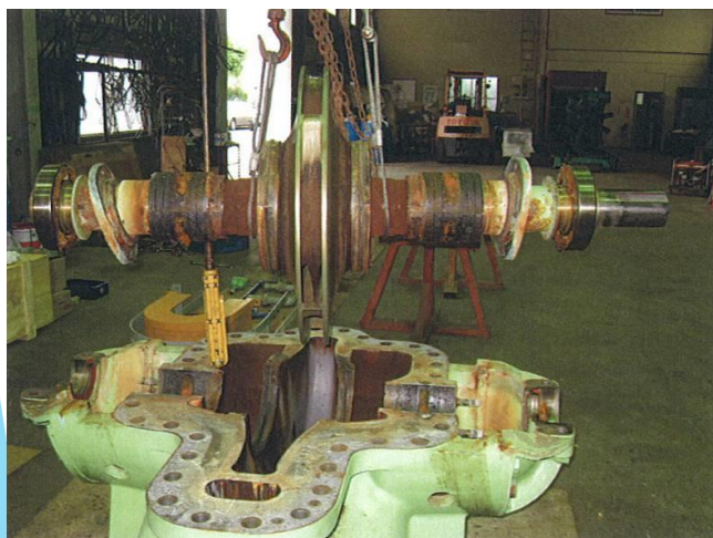
ポンプ整備工事 (機械)
