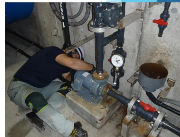
検水ポンプ分解清掃作業 （機械）
