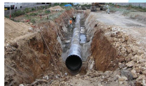
埋設管 (開削工法) 直径0.9メートル
