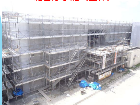
新薬品注入棟建設工事
