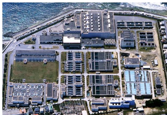
北谷浄水場（全体）
