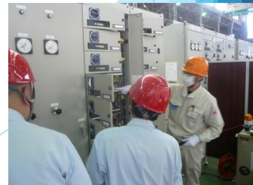
工場検査立会
