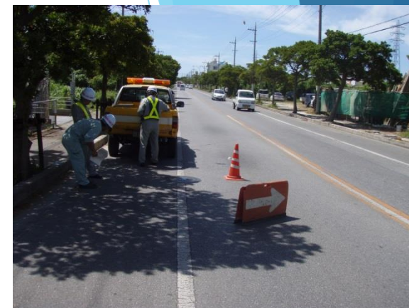
管路点検 （土木）
