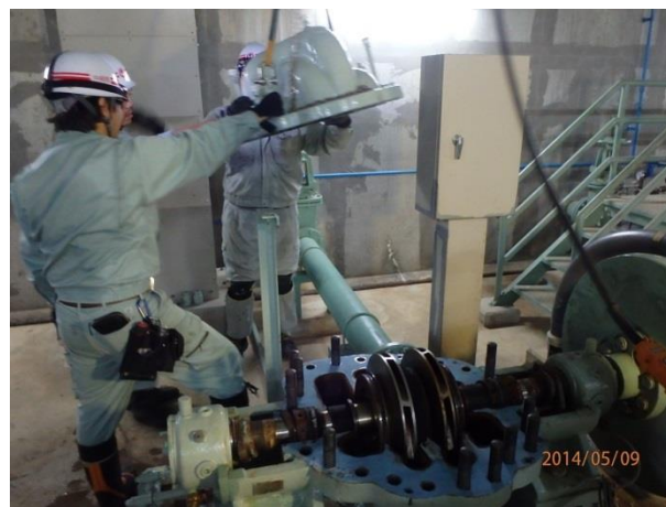
ポンプ動作不良調査の ための分解作業 （機械）
