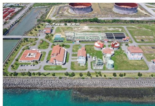
西原浄化センター
