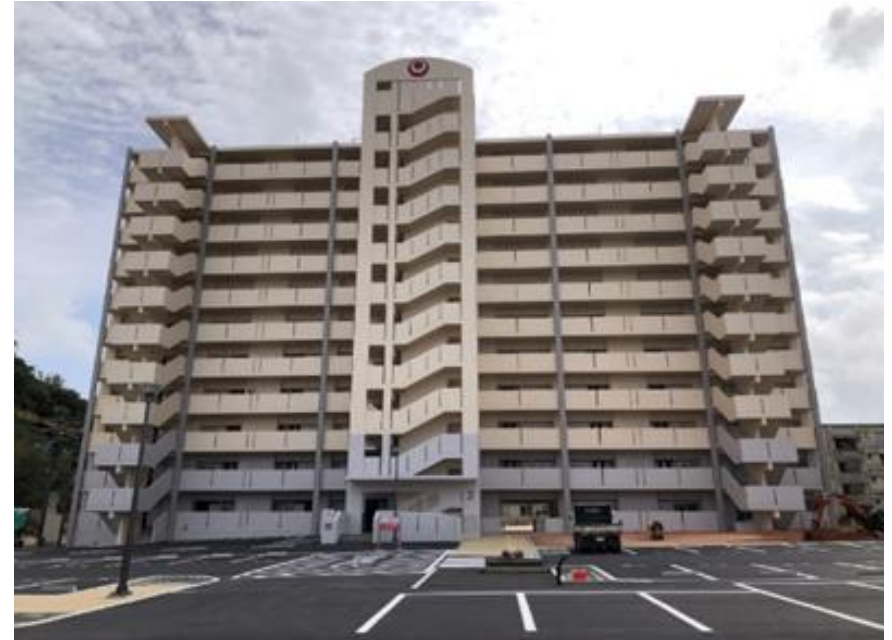
令和5年度に完成した団地（高原団地（第1期））
