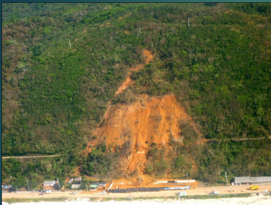
施工前（台風による被災）
