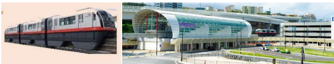
13 出典：沖縄都市モノレール中期経営計画、てだこ浦西駅パークアンドライド駐車場 HP
