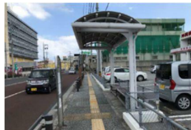
20 民地側を活用している上屋
