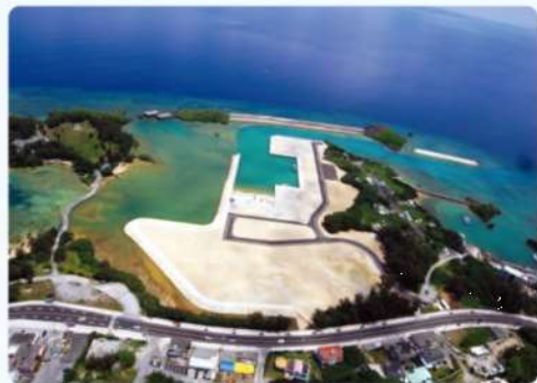
水産物供給基盤整備事業 瀬良垣漁港(R21完了)
