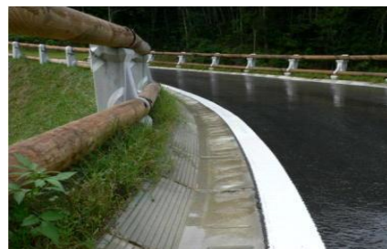
改良型L型側溝（チイバナ林道）
