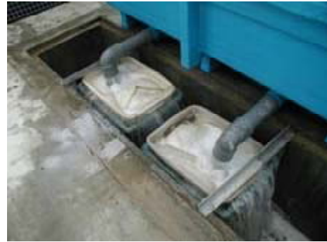
写真15 取上口セットの状況
