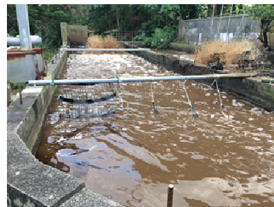
写真4 炭素繊維設置状況
