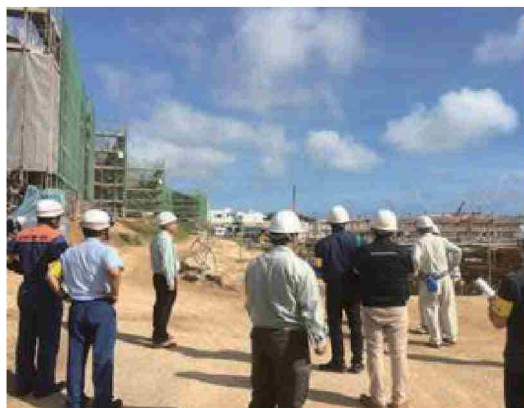
建築パトロールの状況
