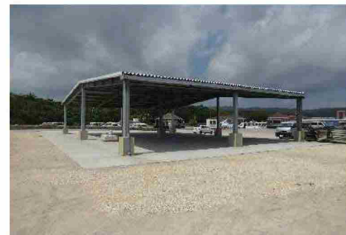
仲間港屋根付き荷捌き施設新設工事
