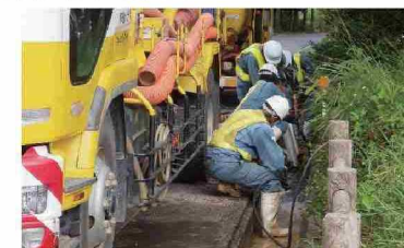
側溝清掃状況
