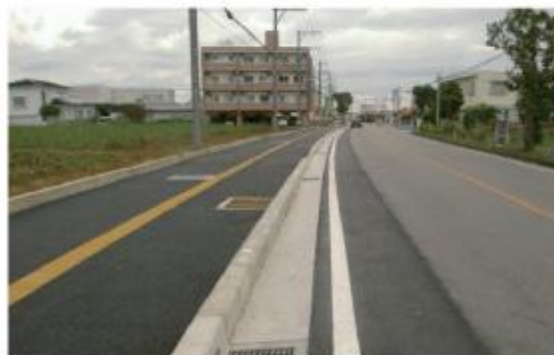
公共交通安全事業(国道390号:大浜)
