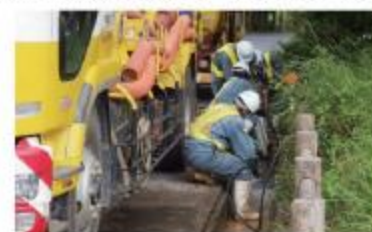
側溝清掃状況
