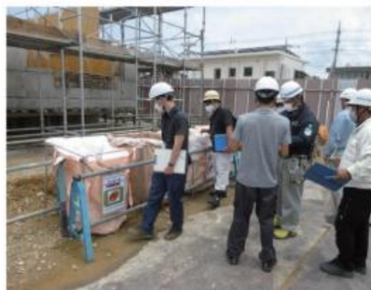
建築パトロールの状況
