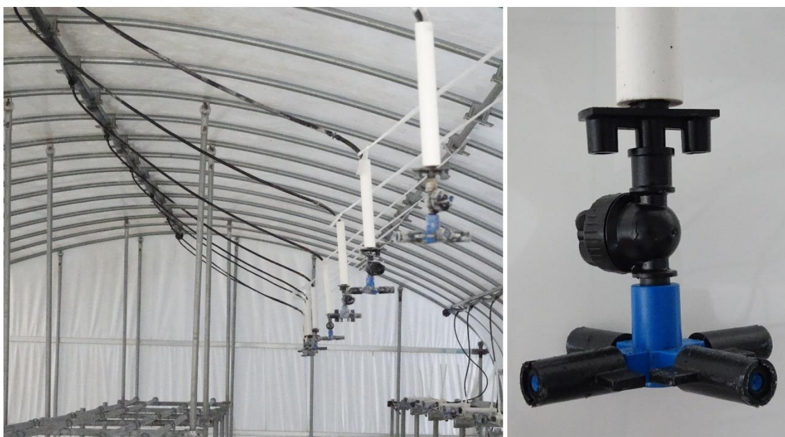
図-16. スプリンクラーの設置例
