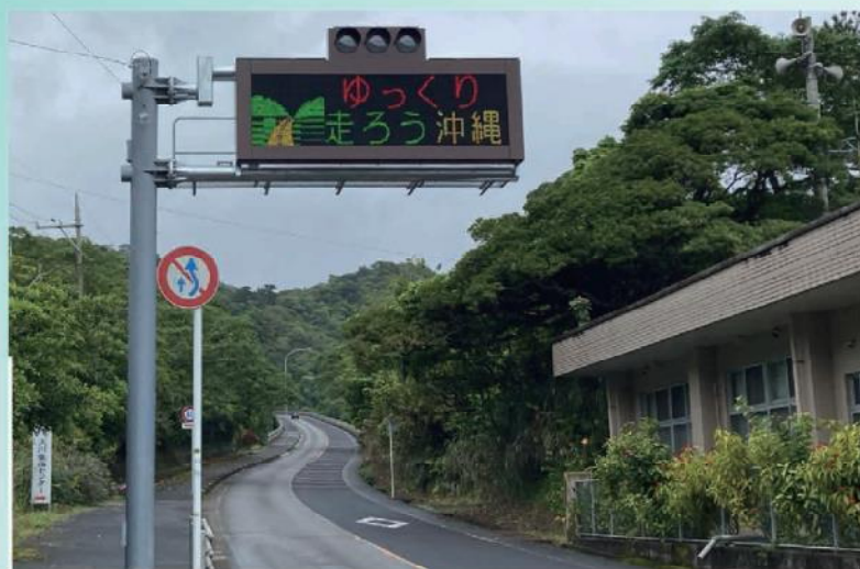
◀道路情報板の設置 (名護市大川)
