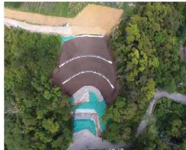
真喜屋地区(名護市、土砂崩壊防止工)
