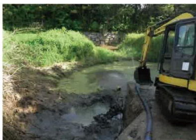
沈砂池の泥上げ
