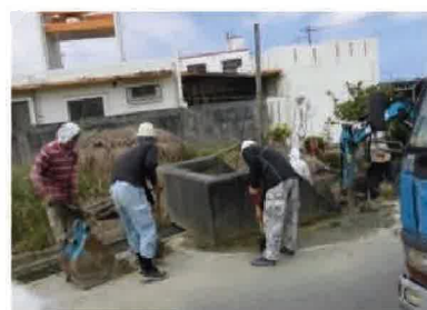
排水路の泥上げ
