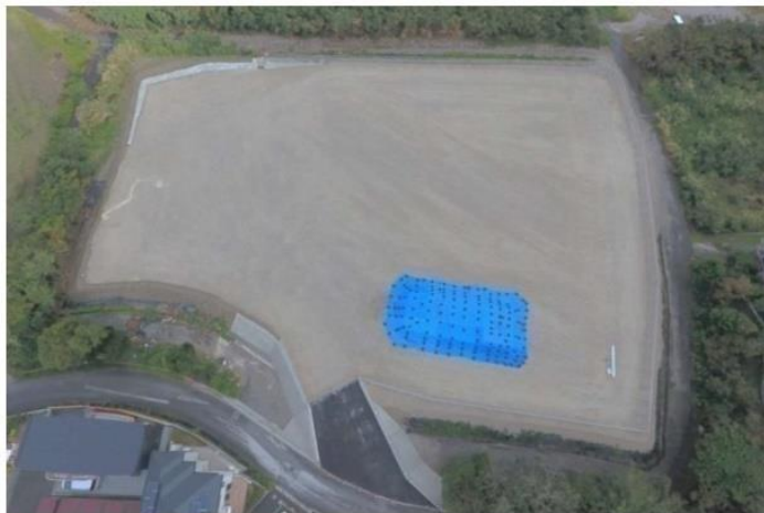
原土保管場所整備状況(R3.12末時点)
