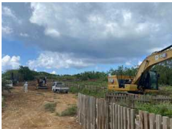
治山事業現場
