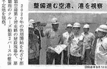
2020年の供用開始をめざす那覇空港第2滑走路の建設現場や、那覇港のクルーズ船第2パースの整備予定地を視察。(2018年9月12日)
