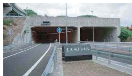
豊見城トンネル
