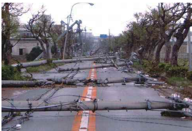
平良城辺線(宮古島市城辺) 平成 15 年台風 14 号で倒壊した電柱
