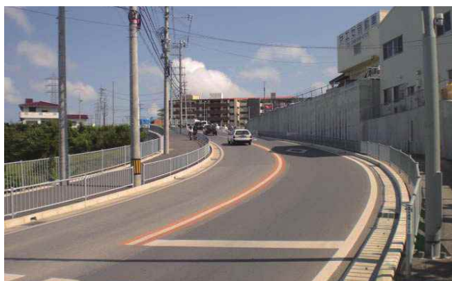
国道507号(八重瀬町伊覇) 公共交通安全事業
