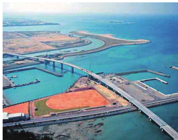
国道331号豊見城道路
