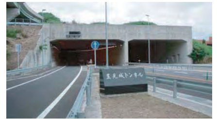
豊見城トンネル
