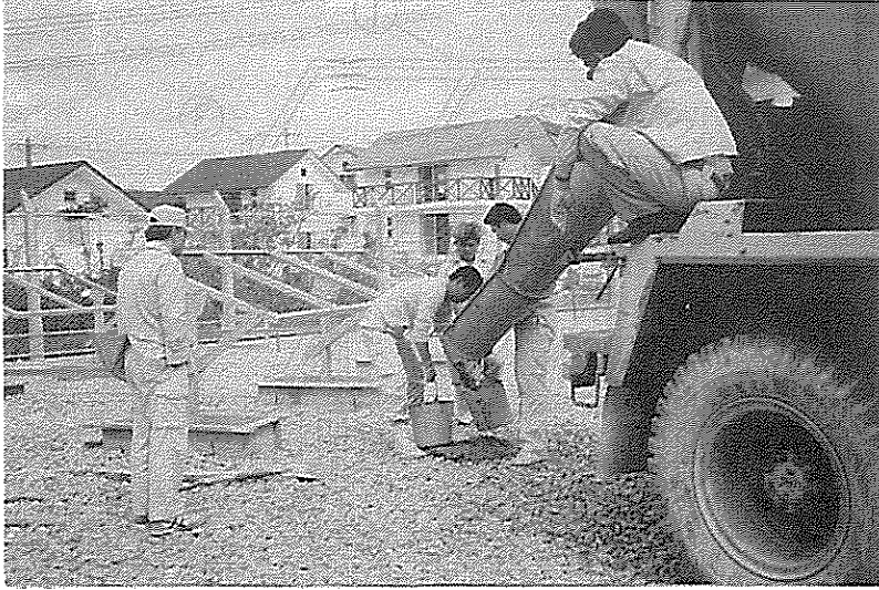
写真-1 : コンクリート基礎打ち (本部暴露場)
