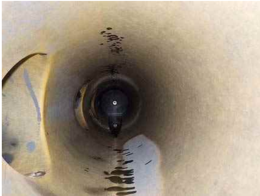
図 3-18 ユニット B 蒸発器 海水ヘッダ配管内
