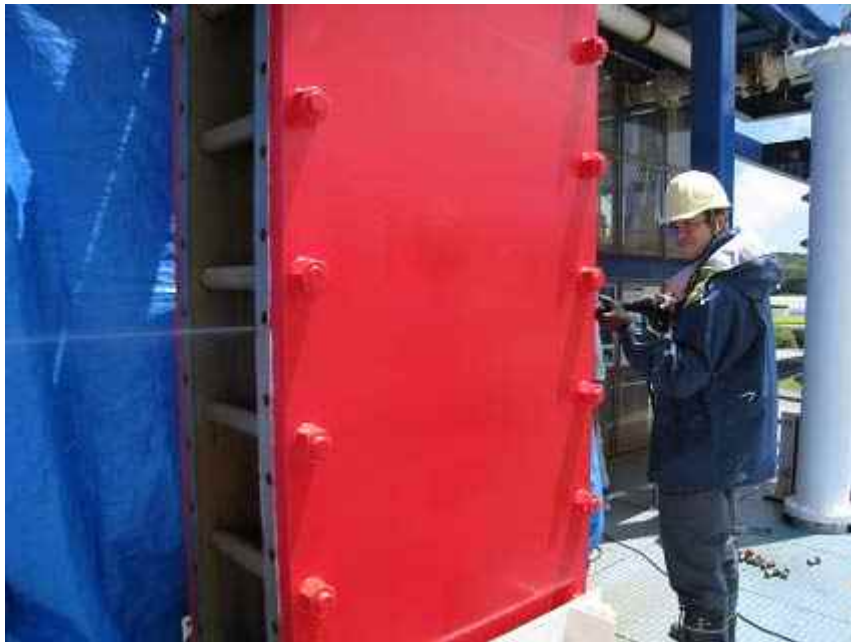
図 3-14 ユニット A 蒸発器ジェット洗浄作業
