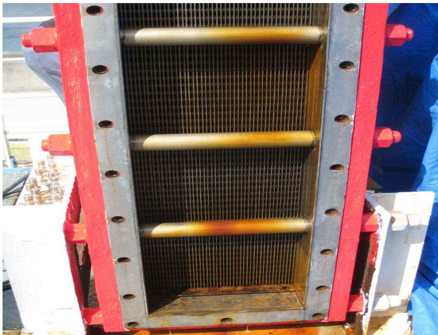
図 3-15 ユニット A 蒸発器 洗浄作業後の状況
