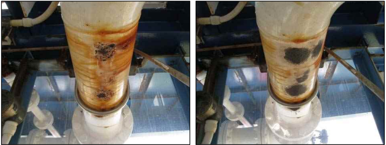
図 2-6 日常メンテナンス例：配管発錆部処理（左：錆びコブ、右：錆取り・ケレン作業）
