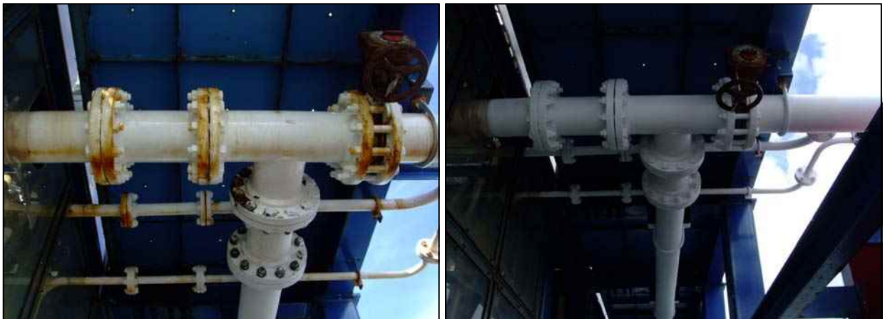
図 2-7 日常メンテナンス例：配管発錆部処理（左：タッチアップ前、右：タッチアップ後）
