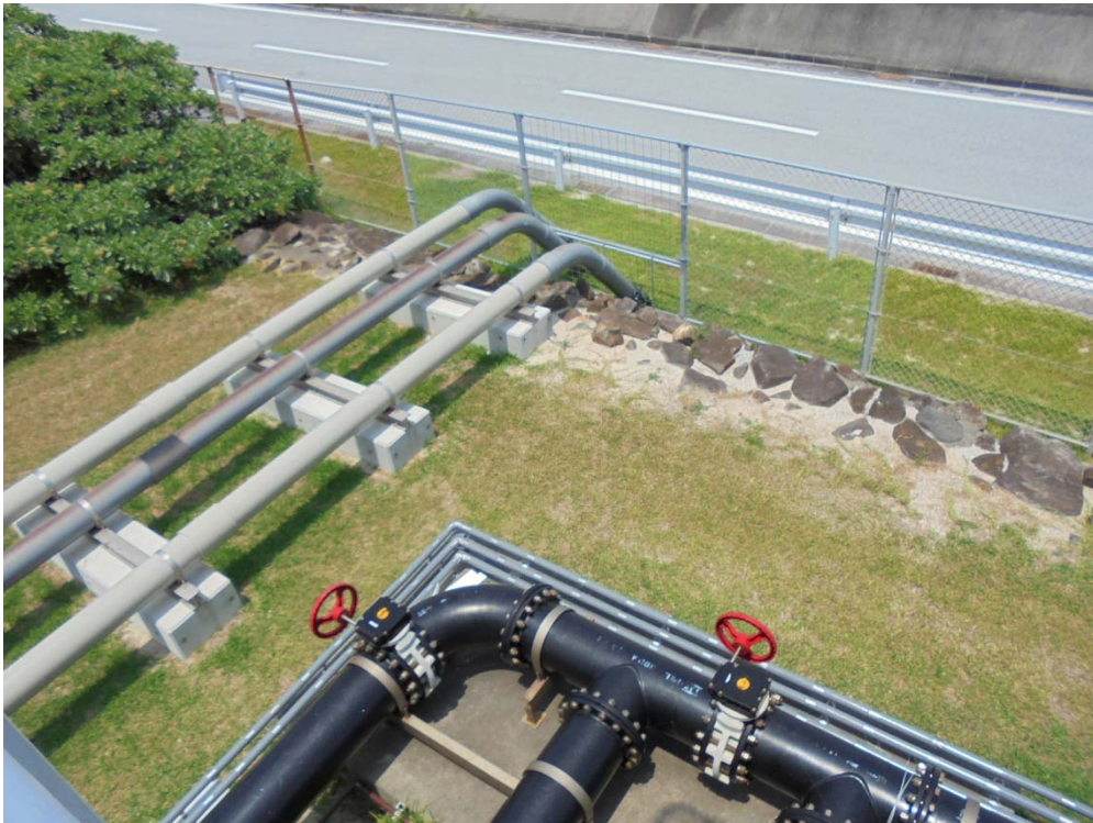
図 2-7 現況写真: 発電後海水配管(研究所敷地境界フェンス部)
