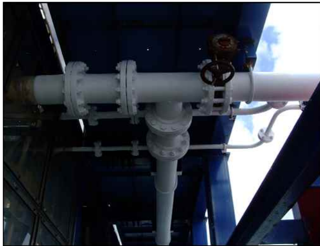
図 3-27 配管発錆部処理(上:タッチアップ前、下:タッチアップ後)
