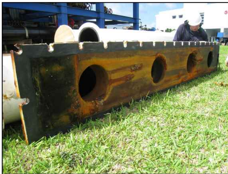
図 3-29 蒸発器 海水ヘッダー取り外し写真(上、中: 取り外し直後、下: ゴムライニング部)
