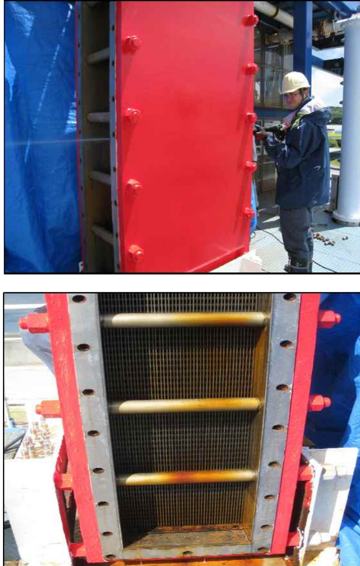
図 3-29 蒸発器 海水ヘッダー取り外し写真(上:ジェット洗浄中、下:ジェット洗浄後)
