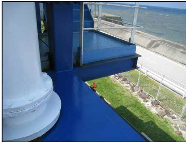
図 3-31 塗装補修作業(上、作業前、下:作業完了時)
