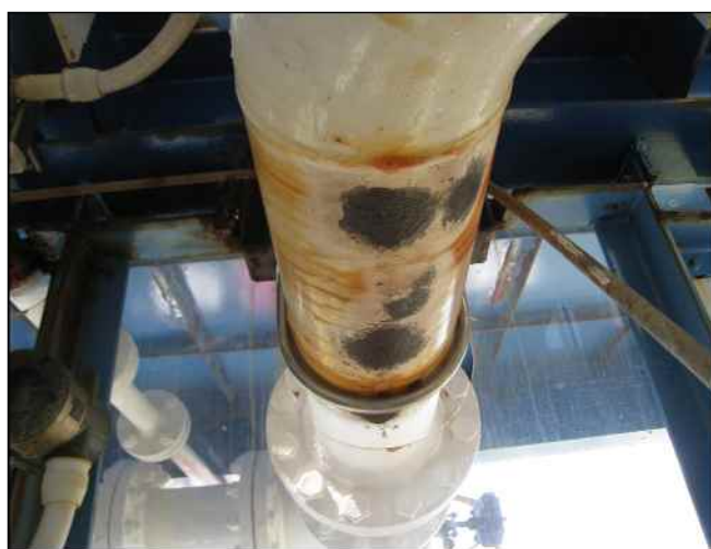
図 3-27 配管発錆部処理(上: 錆びコブ、下: 錆取り・ケレン作業)
