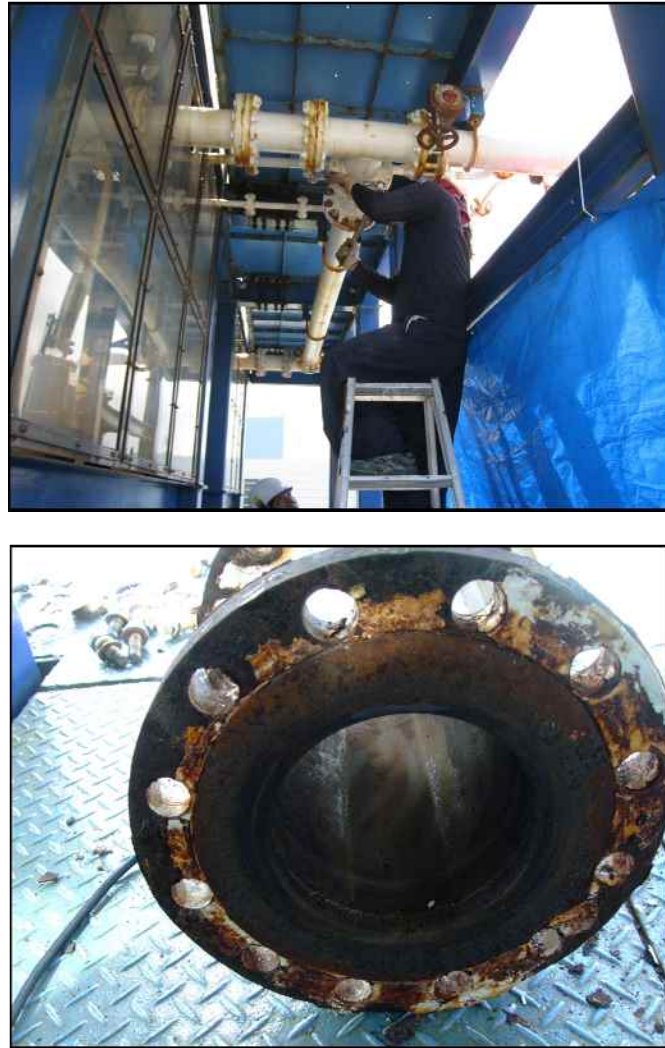
図 3-28 作動流体配管開放(上:フィルター一部取り外し作業、下:短管内部確認)
