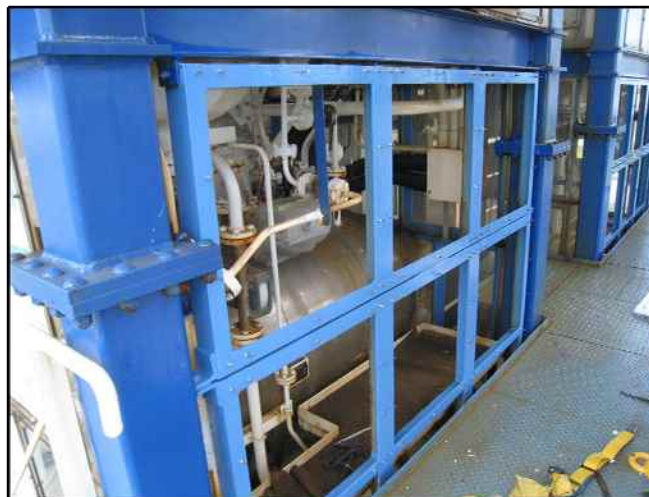
図 3-25 塗装補修の様子(上から、錆取り・ケレン作業、下塗り作業、上塗り作業完了)
