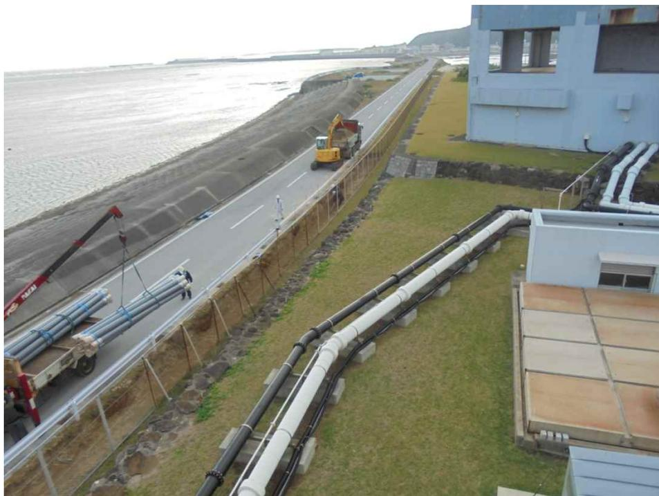
図 3-8 配管搬入(床掘り後)
