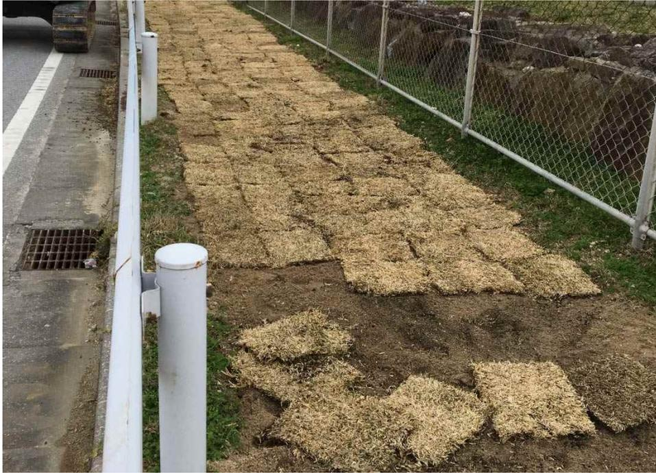
図 3-40 研究所フェンス沿い配管埋設部芝生復旧
