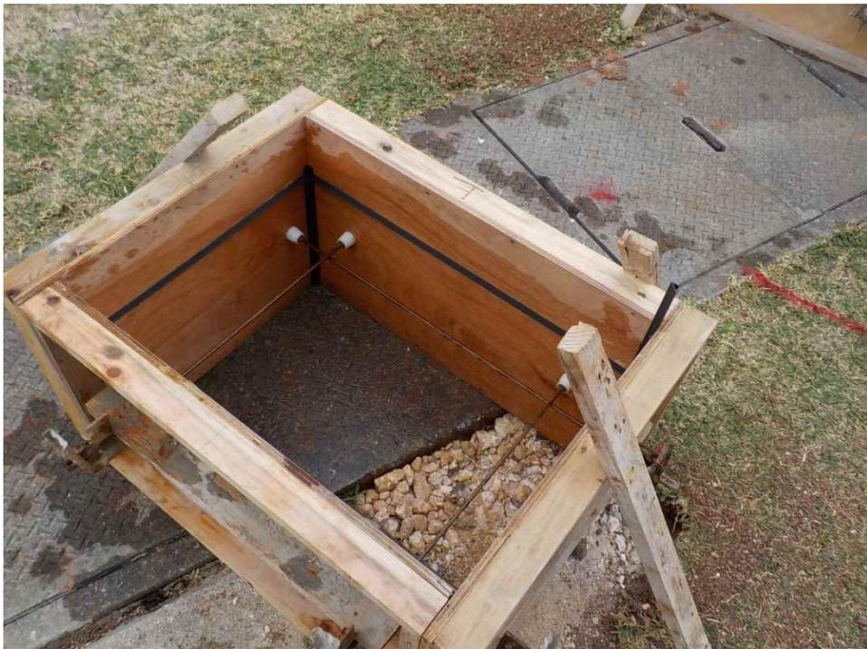
图 3-21 OTEC 横 地上配管部配管架台(RC)型枠準備
