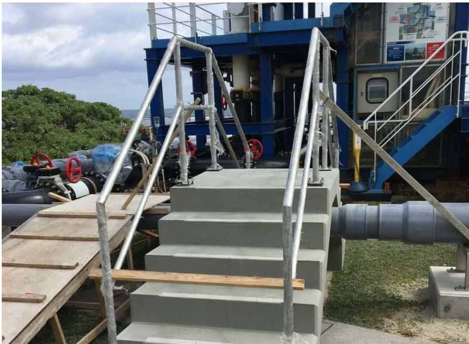
図 3-43 配管をまたぐコンクリート歩道架橋(RC) 手すり設置
