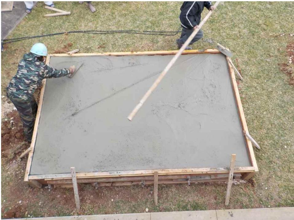
図 3-25 OTEC 横 地上配管部配管架台(RC)コンクリート打設
