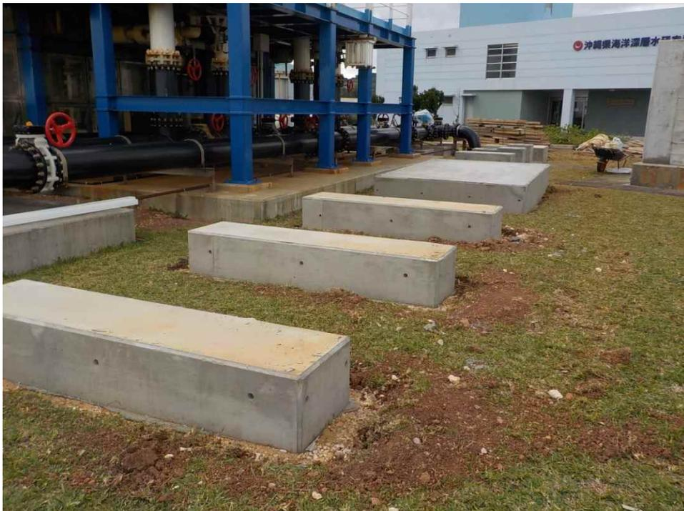
图 3-27 OTEC 横 地上配管部配管架台(RC)完成
