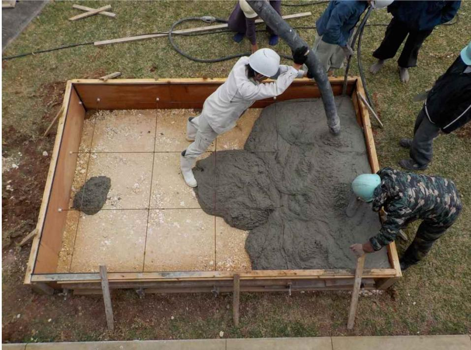
図 3-24 OTEC 横 地上配管部配管架台(RC)コンクリート打設
