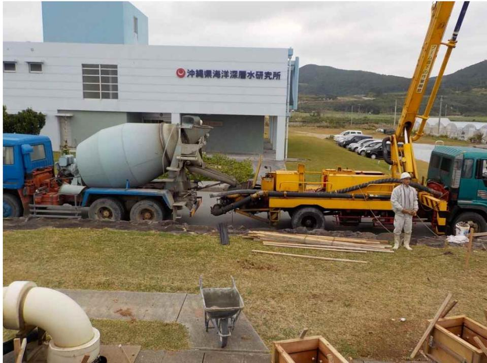
図 3-22 OTEC 横 地上配管部配管架台(RC)コンクリート打設
