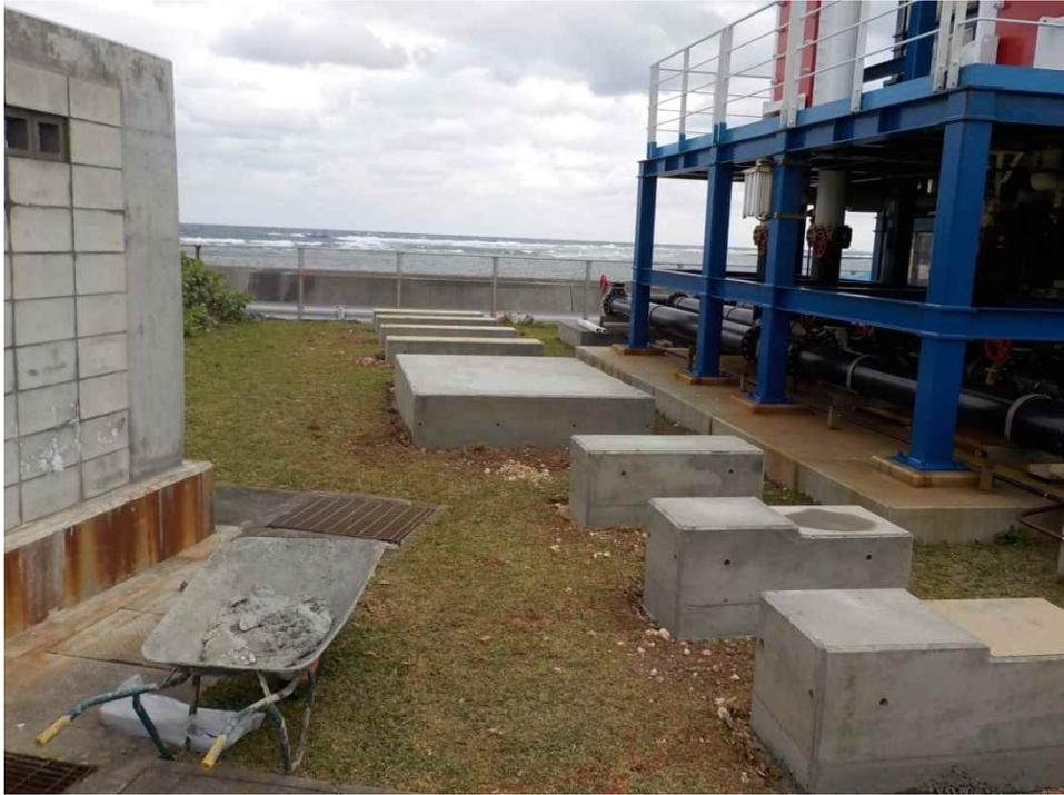
图 3-26 OTEC 横 地上配管部配管架台(RC)型粹撤去
