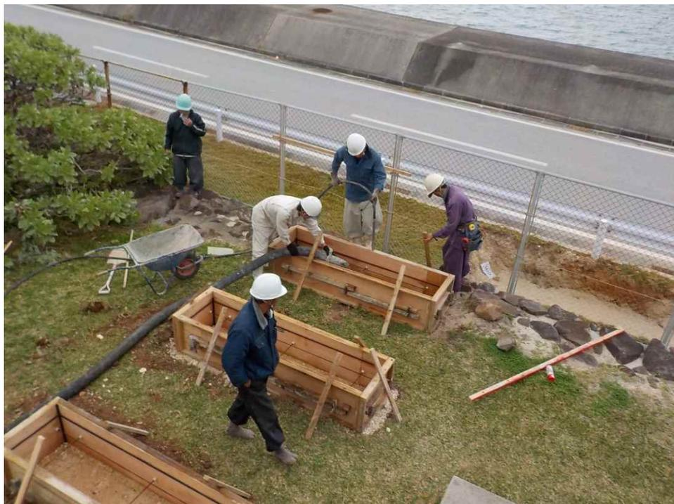
図 3-23 OTEC 横 地上配管部配管架台(RC)コンクリート打設
