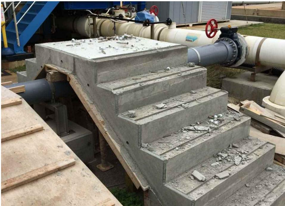
図 3-41 配管をまたぐコンクリート歩道架橋(RC)型枠撤去
