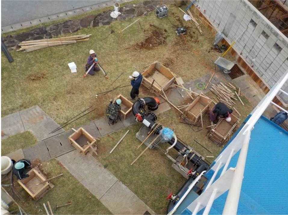
图 3-20 OTEC 横 地上配管部配管架台(RC)型枠準備
