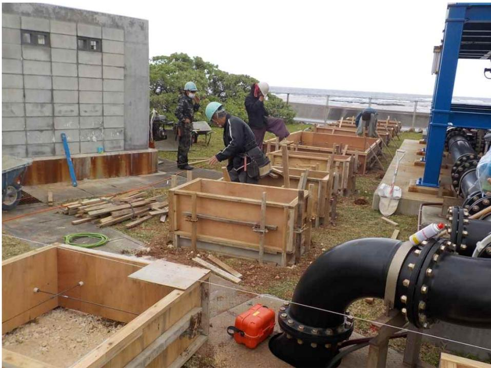
図 3-19 OTEC 横 地上配管部配管架台(RC)型枠準備
