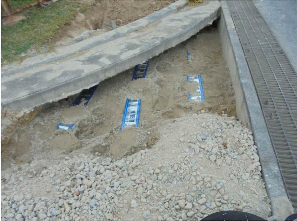
図 3-18 将来の道路工事時の配管破損防止用標示帯
