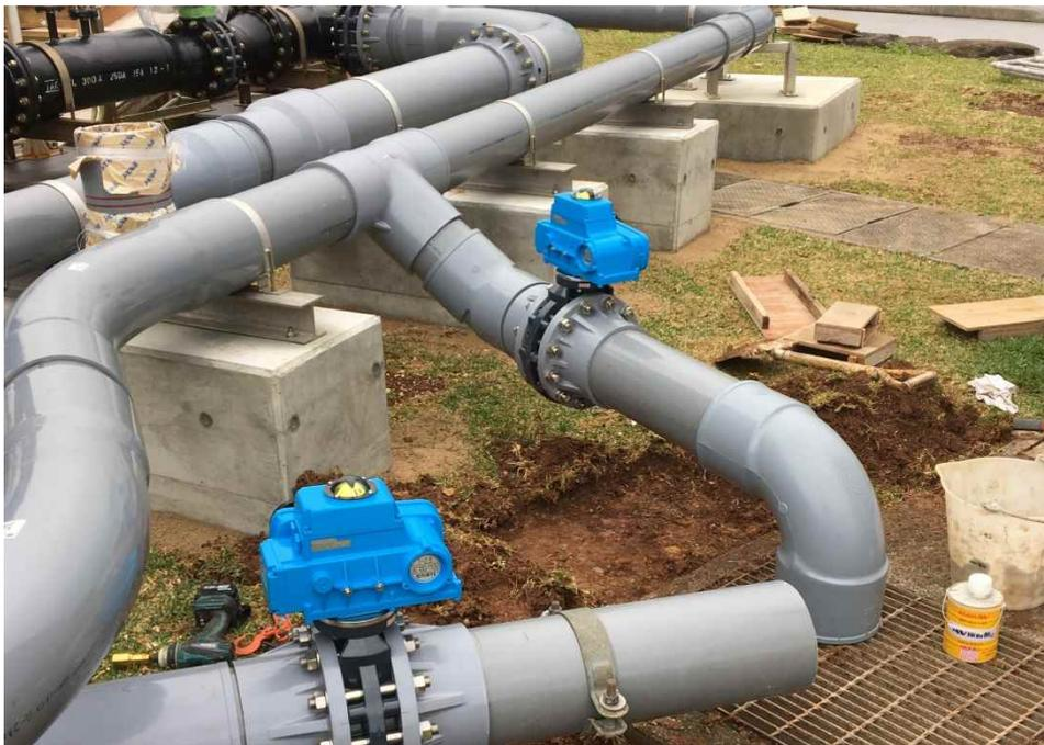
図 3-37 電動弁の設置
