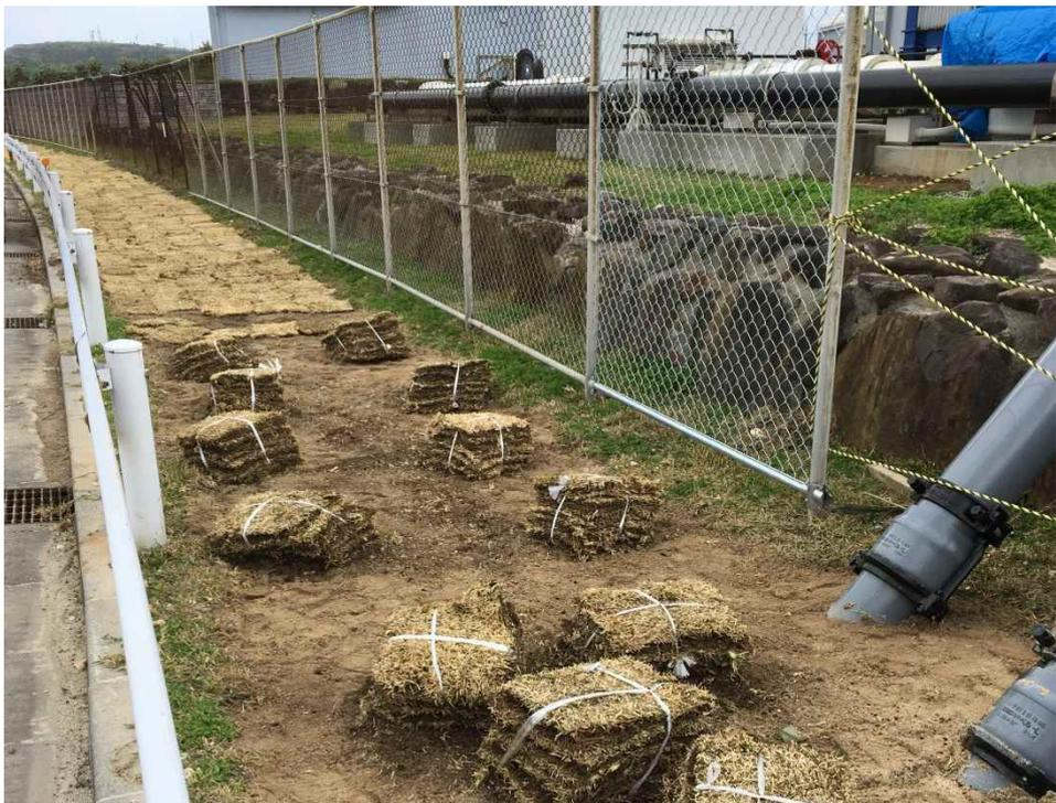
図 3-39 研究所フェンス沿い配管埋設部芝生復旧
