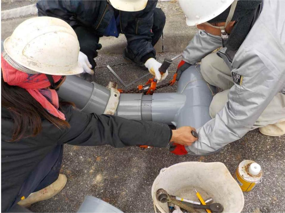
图 3-28 配管接合部施工
