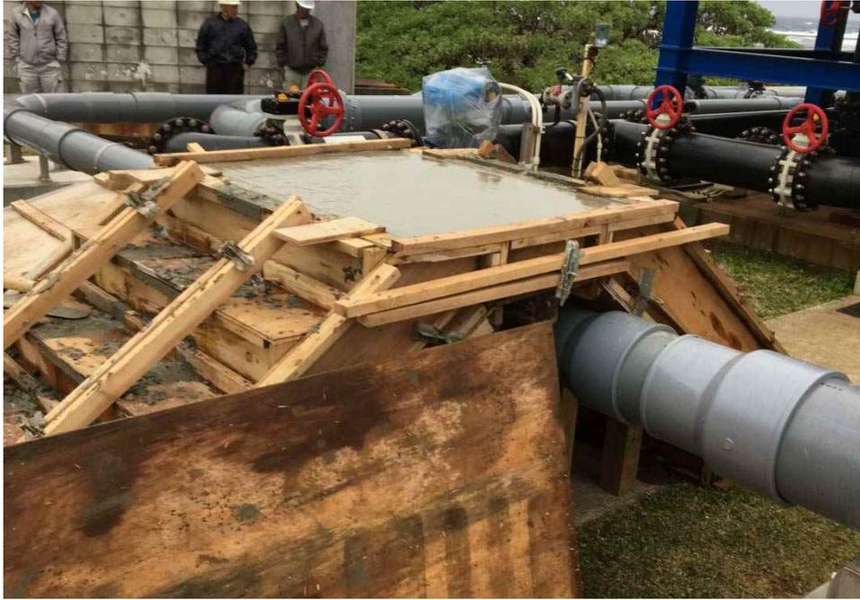
図 3-38 配管をまたぐコンクリート歩道架橋(RC)コンクリート打設
