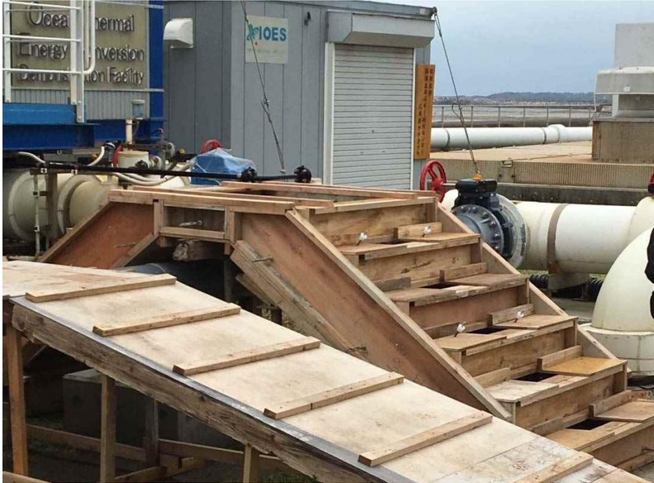
図 3-36 配管をまたぐコンクリート歩道架橋(RC)型枠
