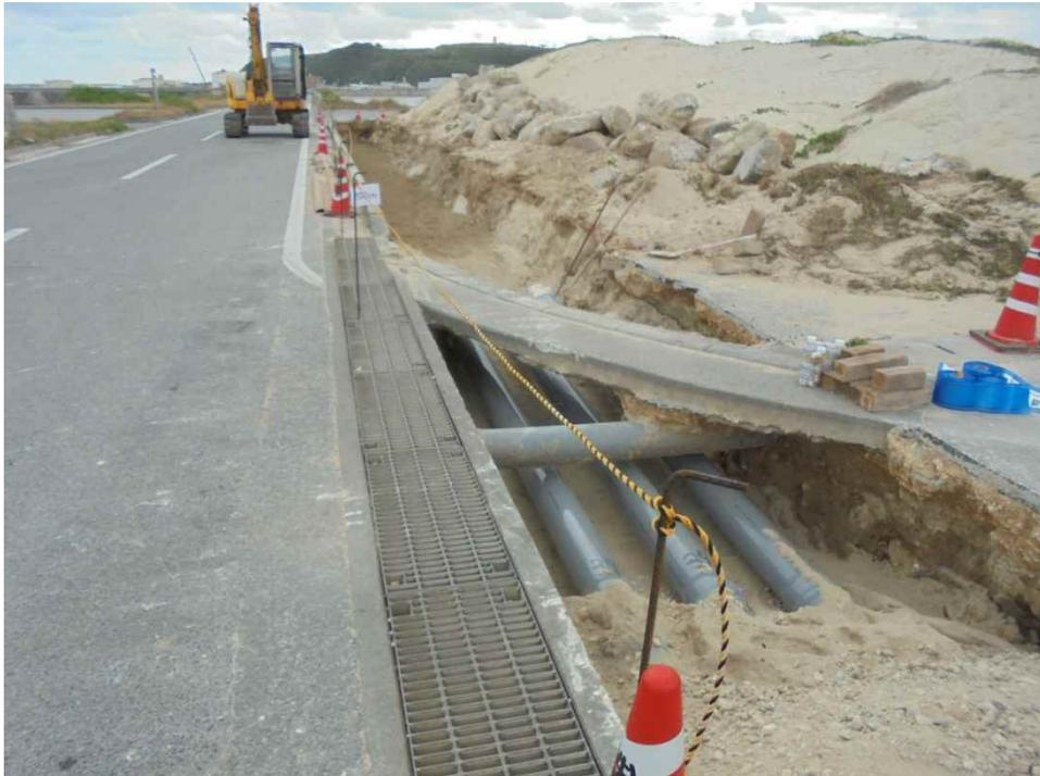
図 3-17 舗装道路横断部布設・埋め戻し
