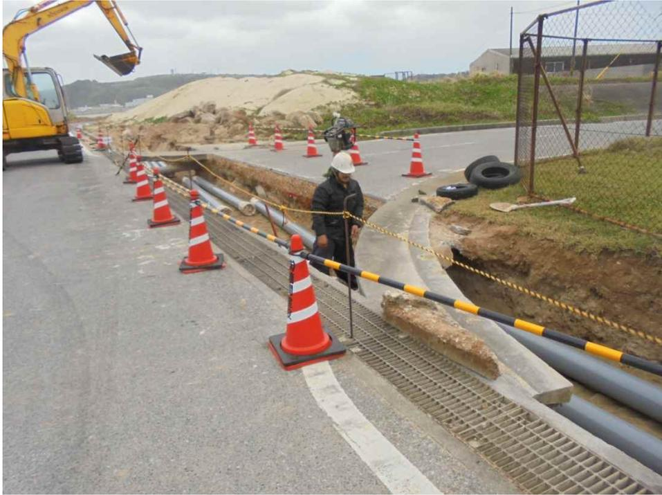
図 3-16 舗装道路横断部布設
