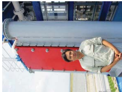
発電効率のカギを握る熱交換装置(赤い部分)
