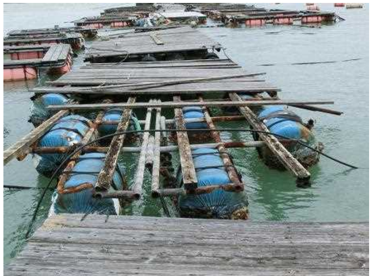
大破した浮棧橋(H6年度整備分)
