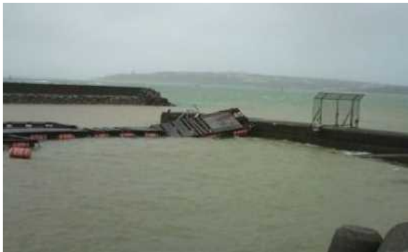
写真-1 突堤に乗り上げた浮棧橋
