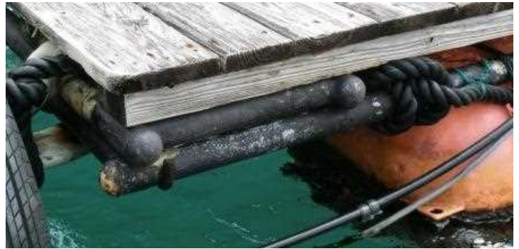
写真－9 左と同じくFRP処理した浮棧橋 (平成16年度に取り替え)
