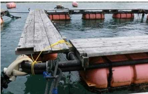
写真－10 鋼管の駆体をFRP処理した生簀 (平成16年度に取り替え)
