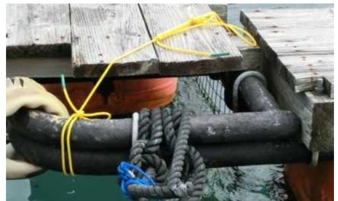
写真11 左と同じくFRP処理した海面生簀の拡大 (平成16年度に取り替え)
