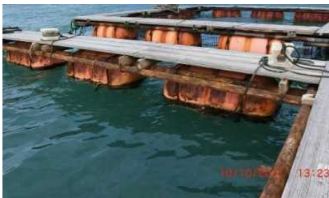
写真－6 サビで老朽化の進んだ海面生簀
