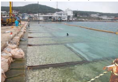
漁港工事 施工状況
