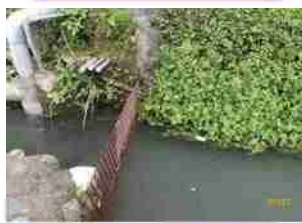
仁里橋南岸大排
