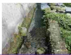
宜昌橋南岸大排渠道
