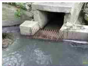
嘉里C區大排渠道
