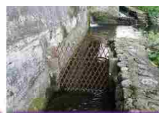
仁里2號橋南岸大排
