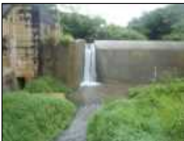
②河川中流域の砂防ダム
