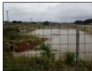
②沈砂池の造成
