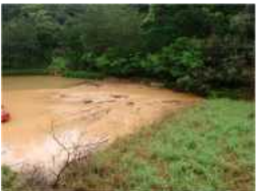
平良川河口 砂防ダム直上の滞留泥分 (平成 24 年度)
