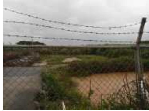
真謝川河口 泥分が堆積・懸濁した沈砂池状況（平成 27 年度）
