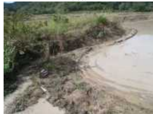
川平湾 水田からの赤土等流出(平成 25 年度)
