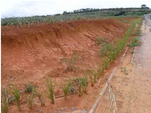
地点⑤ 道路への流出痕(但しグリーンベルト対策あり)
