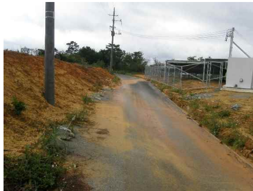
地点⑧ 太陽光発電パネル設置状況
