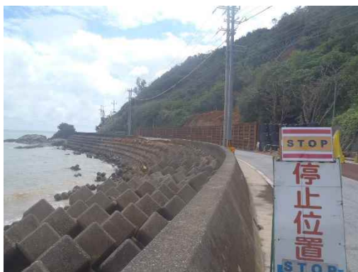
土砂崩れ箇所対策
