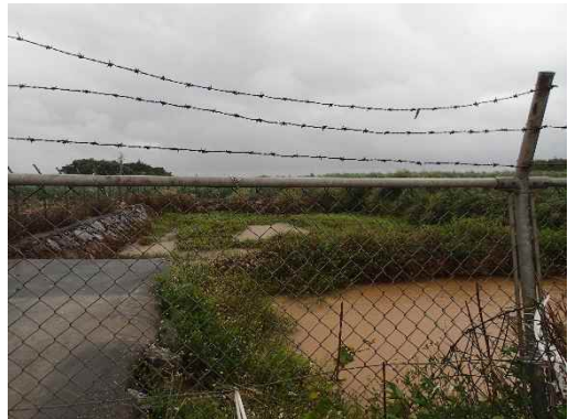
真謝川河口 泥分が堆積・懸濁した沈砂池状況（今年度）
