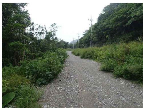
地点③ 砂利が敷き詰められた道路
