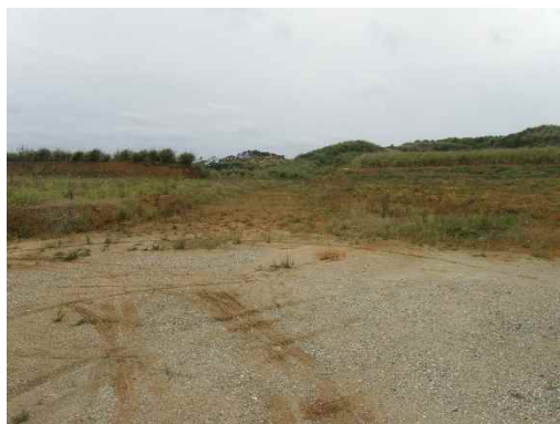
地点⑭ 残土置き場及び材料山の復旧状況(砂利敷き)
