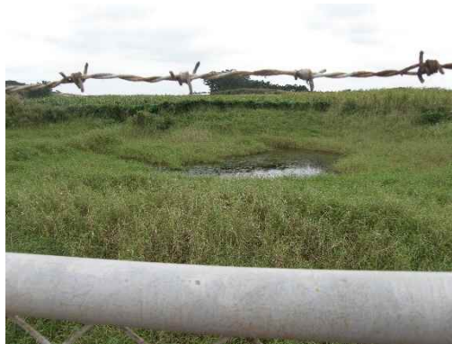
地点⑦ 沈砂池の状況
