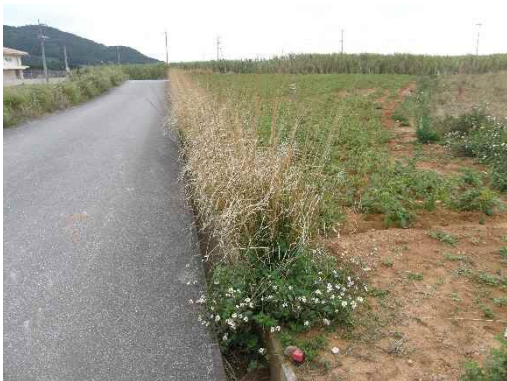
地点⑪ グリーンベルト対策(改善)
