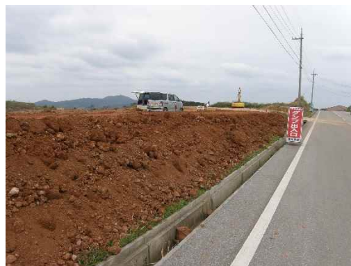
地点⑯ 新規造成地と水路状況
