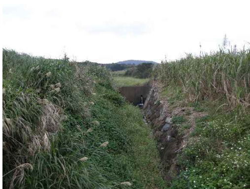
地点⑦ 沈砂池下流側状況
