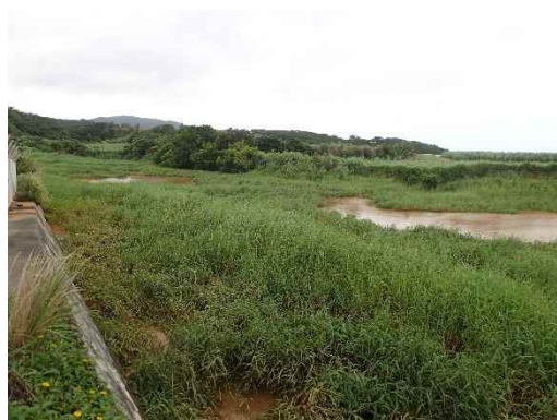
地点⑦ 沈砂池の状況
