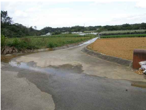
地点③ 畑から道路への赤土流出痕(変化無し)
