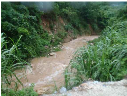
地点⑫ 沈砂池直下の状況
