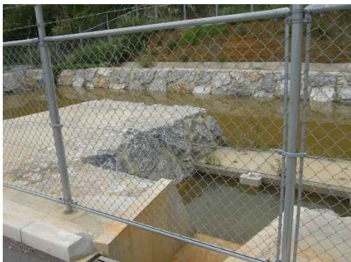
地点⑨ 新規沈砂池
