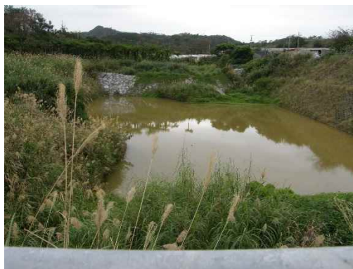
地点⑥ 沈砂池の状況
