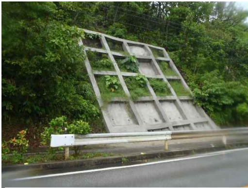
地点⑨ コンクリートで覆われた斜面
