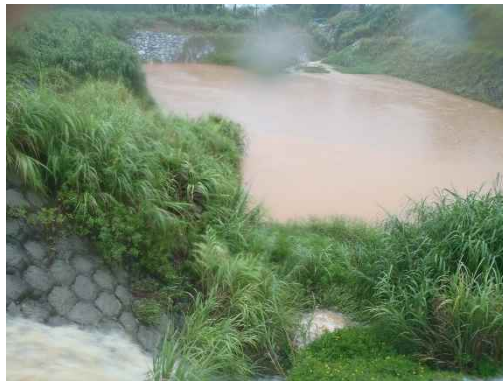
地点⑩ 沈砂池の状況
