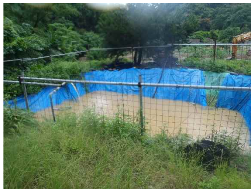
地点⑬ 沈砂池
