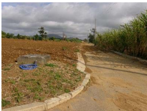
地点 道路への流出痕
