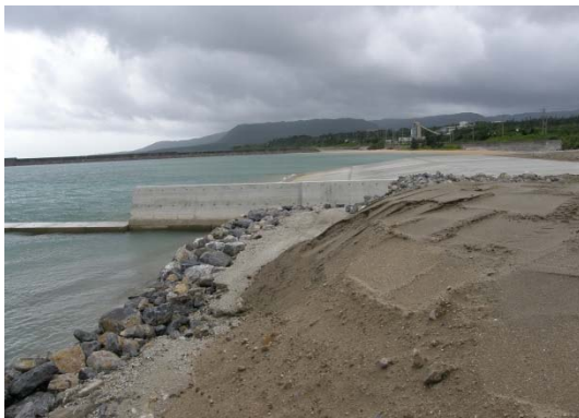
地点 今年度の状況(工事終了)
