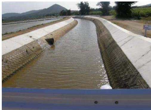
地点 河川整備工事完了写真
