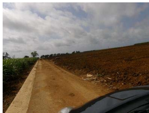
地点 流出源となりうる箇所
