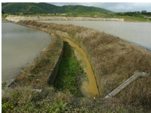
地点 水田脇の排水路
