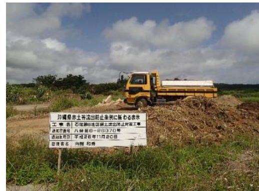
地点 造成裸地と工事看板
