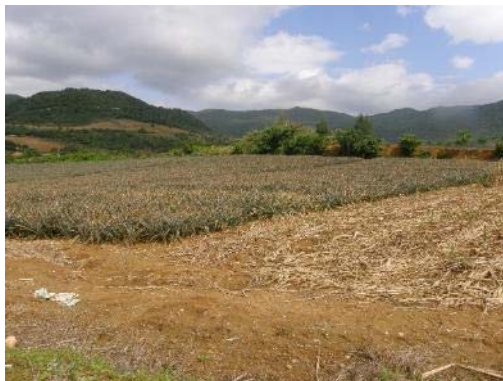
地点 造成工事（第 1 回目地点 ）
