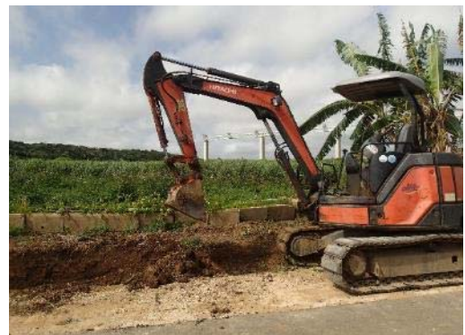
地点 排水路改良工事
