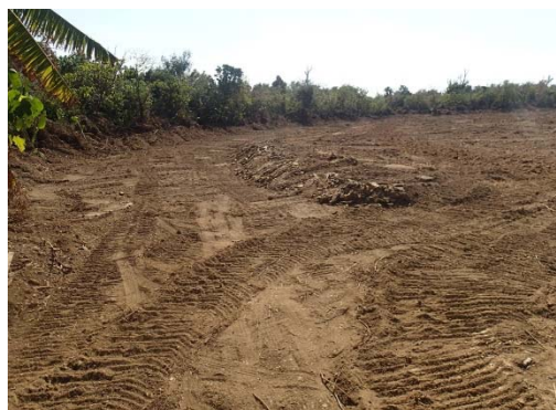
地点 造成裸地
