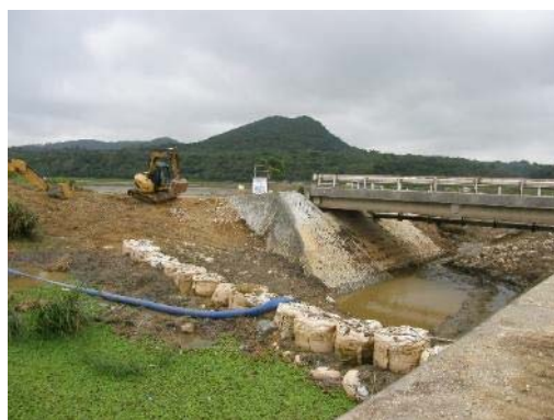
地点 用水路工事の状況
