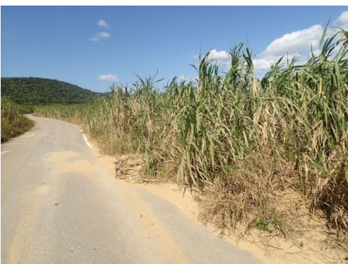
地点 道路への流出痕
