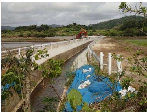
地点 工事状況
