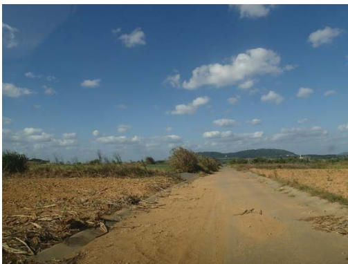
地点 道路への流出痕
