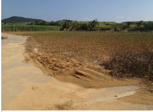
地点 道路への流出痕
