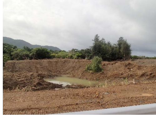
地点 新規造成地の状況
