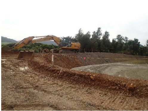
地点 新規造成地の状況
