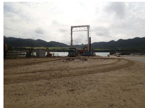
地点 浚渫工事状況
