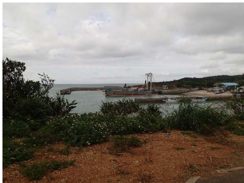
地点 浚渫工事の概観
