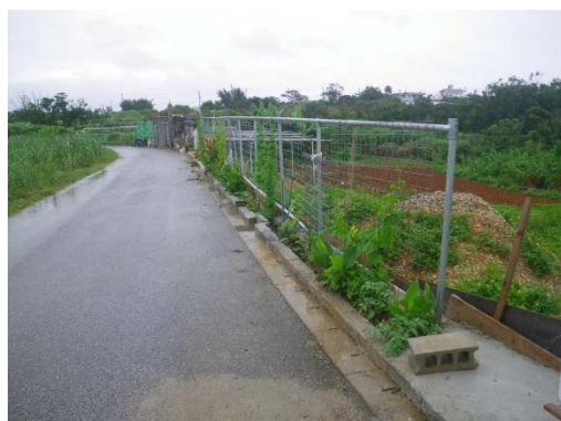
地点 改善状況
