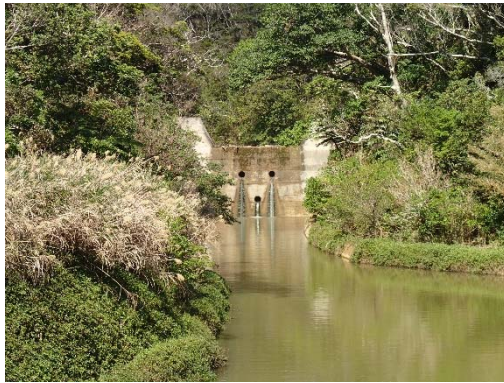
地点 砂防ダム付近の状況
