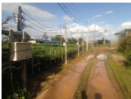
地点 前回確認流出箇所(1 回目地点 )
