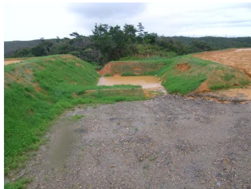
地点 沈砂池造成
