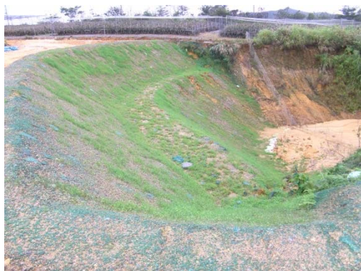
地点 法面緑化状況
