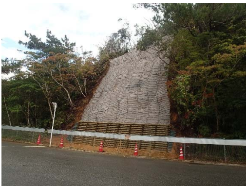
地点◎ 土砂崩れ箇所対策
