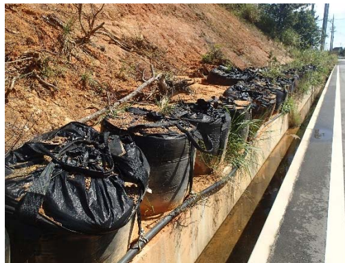
地点 土砂崩れ箇所対策(1回目地点)
