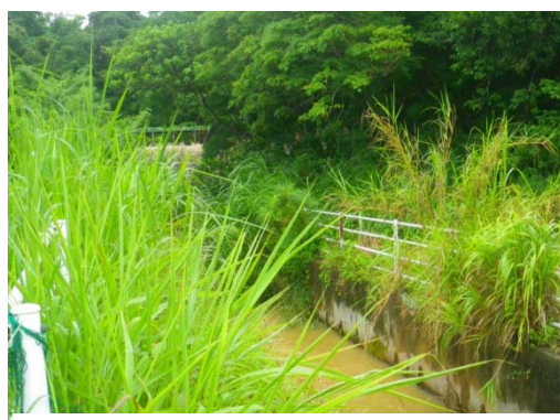
地点 堰から濁水が越流
