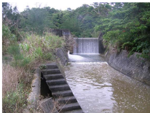
地点 砂防ダムからの放水、越流
