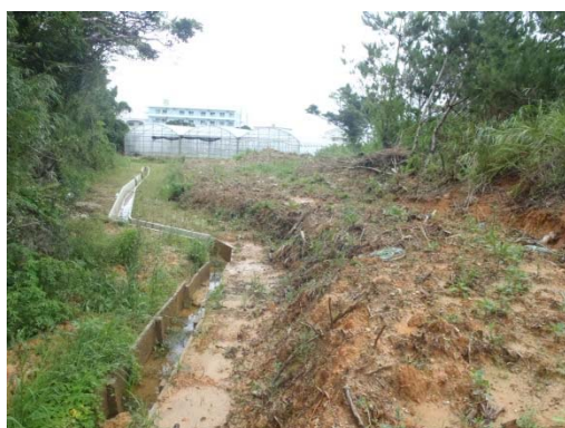
地点 造成水路横の裸地
