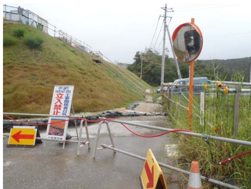
地点 法面緑化と沈砂池
