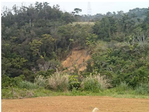
地点 がけ崩れ後の状況
