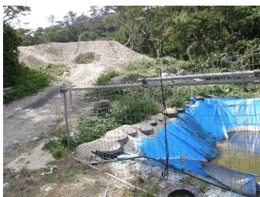
地点 新規造成地と沈砂池
