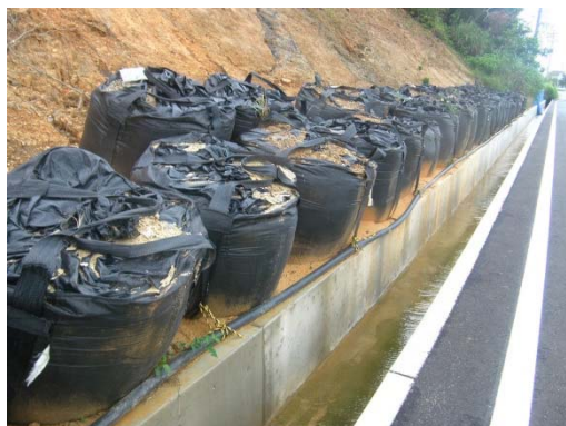
地点 土砂崩れ箇所対策
