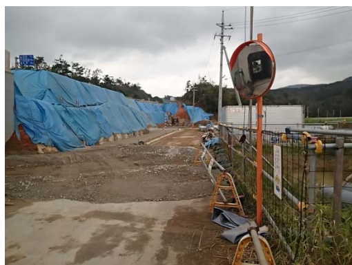
地点 法面緑化と沈砂池(1 回目地点 )
