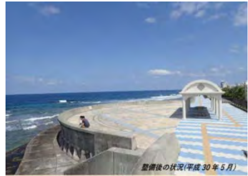
図 II-3 整備後の宮城海岸の状況
