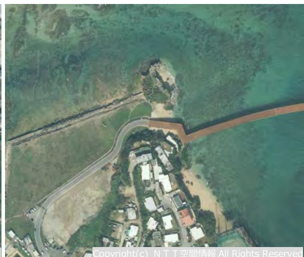
図 II-17 視察箇所<カーミージ (空寿崎)>
