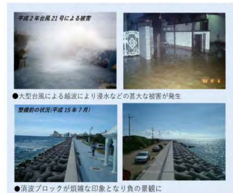
図Ⅱ-1 整備前の宮城海岸の状況
