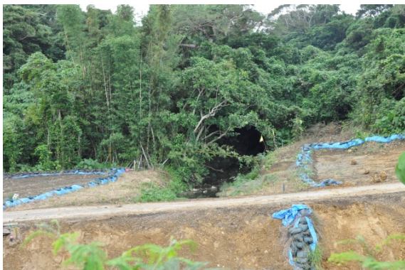
基地内巡回路の工事状況
