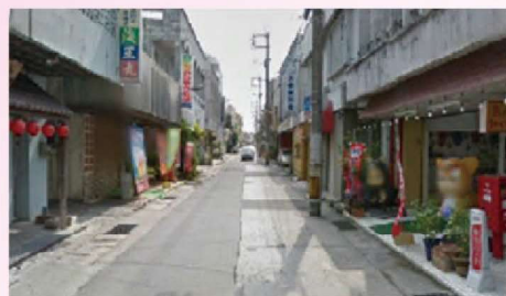
補修前（西里通り）
