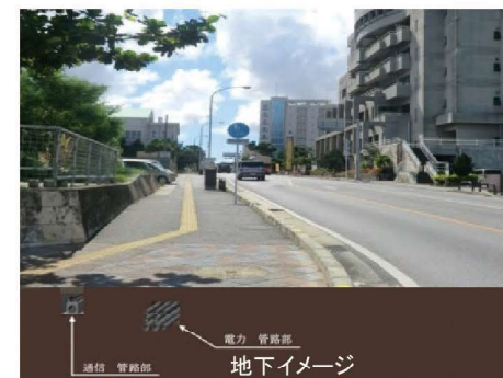
無電柱化整備後
