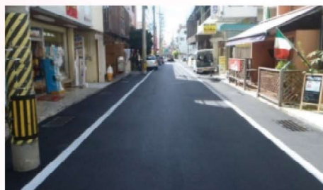
補修後（西里通り）
