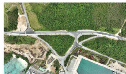
整備後(令和4年度供用開始)
